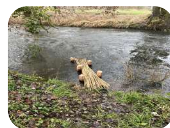
Vues après travaux : Protection de berge sur la berge droite, épis déflecteurs en aval de l'ouvrage
