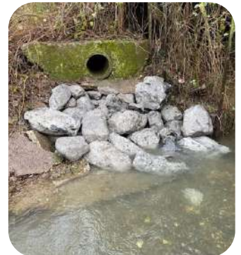
Vue du rejet après intervention
