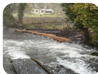
Vues après travaux : Protection de berge sur la berge droite, épis déflecteurs en aval de l'ouvrage
